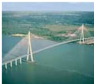
Pont de Normandie
