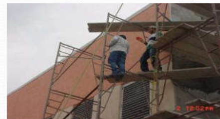
▲ فعالیت نا ایمن و بدون تجهیزات حفاظتی بر روی داربست
