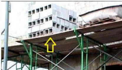
▲ بارگذاری بیش از حد مجاز بر روی سکوی کار و شکم دادن چوب بست
