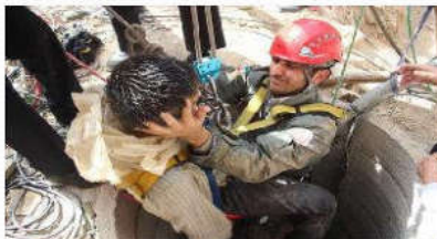
▲ مرگ کارگر مقنی در حین حفر چاه بخاطر برق گرفتگی
