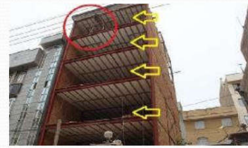
▲ عبور کابل های برق از مقابل بالابر (عدم رعایت حریم ایمنی)
