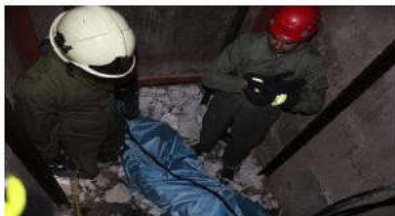
▲ سقوط و مرگ کارگر به داخل چاه آسانسور . فقدان نرده حفاظتی
