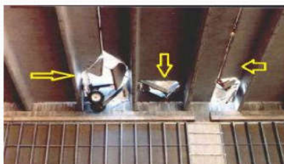
▲ دهانه با زشو حفاظت نشده و افتادن وسایل و تجهیزات در آن
