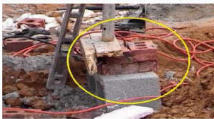
▲ نقض ایمنی در برپایی داربست و عدم تعادل پایه آن
