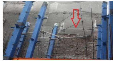
▲ ریزش دیواره تحکیم شده و آسیب دیدن داربست و سکوی کار مقابل
