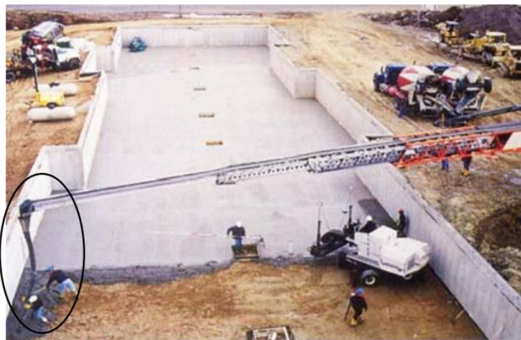
شکل ۵ - شوت قوطی، سمت راست انتقال بتن با استفاده از شوت سقوطی، سمت چپ ترکیب ناوه و شوت سقوطی
