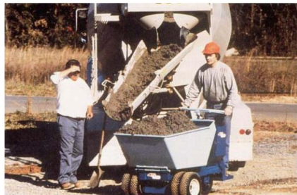
شکل ۲ انتقال بتن با استفاده از فرغون موتوری
