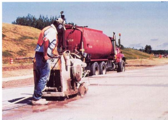
شکل ۱ استفاده از دستگاه برش برای ایجاد درز
