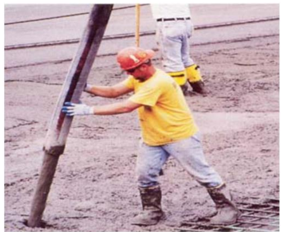
شکل ۵ - شوت قوطی، سمت راست انتقال بتن با استفاده از شوت سقوطی، سمت چپ ترکیب ناوه و شوت سقوطی
