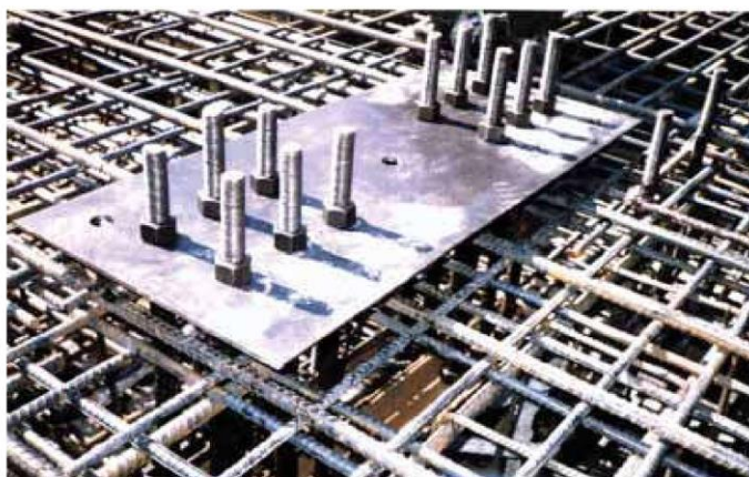
شکل ۱-۲ استقرار صفحه ی کف ستون (Baseplate) در فونداسیون گسترده
