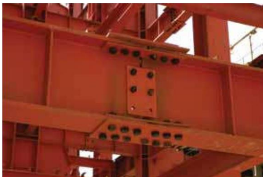
شکل ۴-۳۳- نحوه ی طویل کردن تیرها
