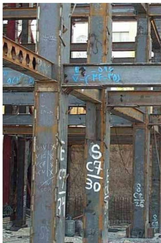
شکل ۴-۳ انواع اتصال تیر به ستون
