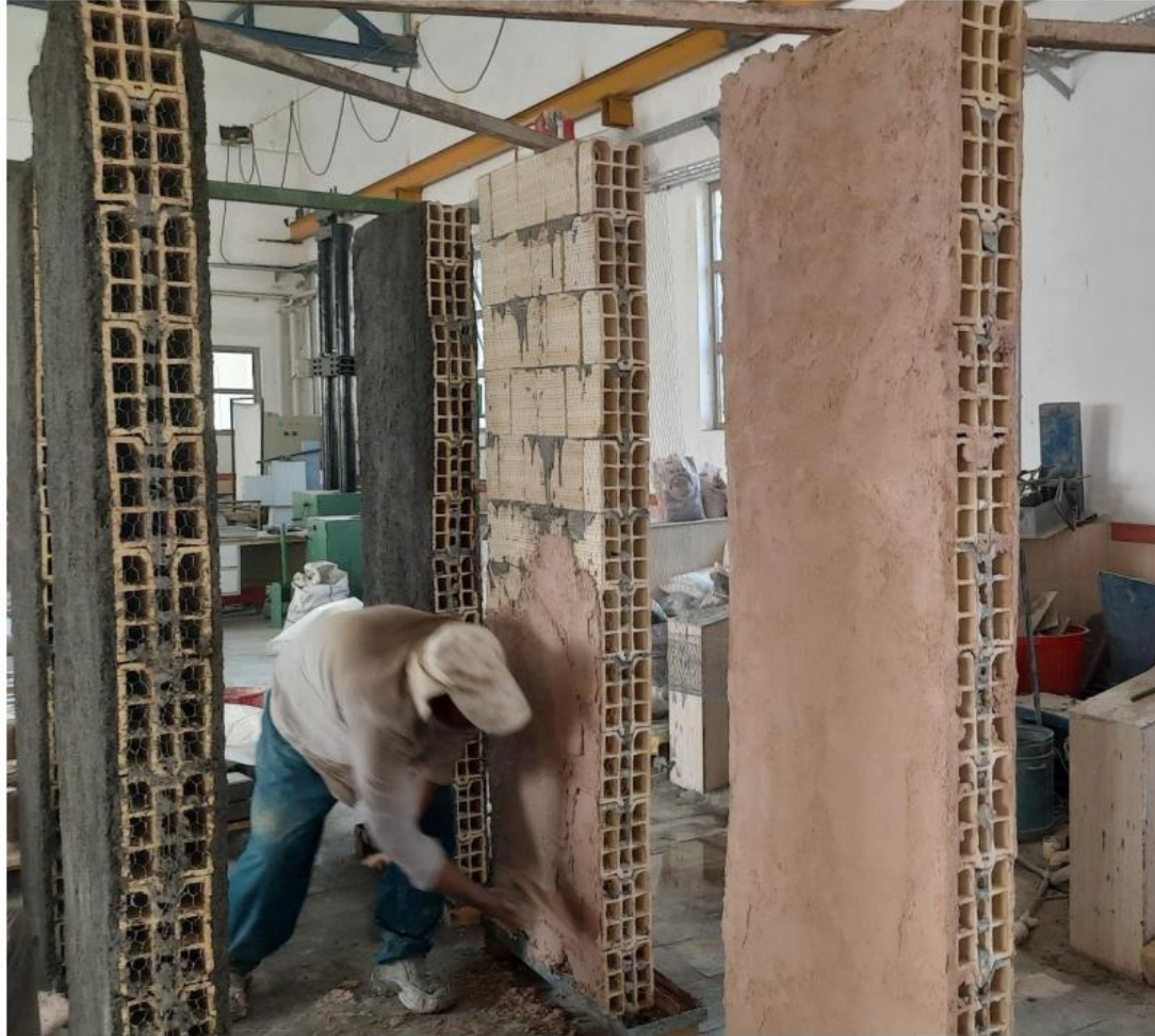
شکل ۷-۸: نحوه دیوارچینی و اجرای پلاستر روی دیوارهای بلوک سفال پازلی
