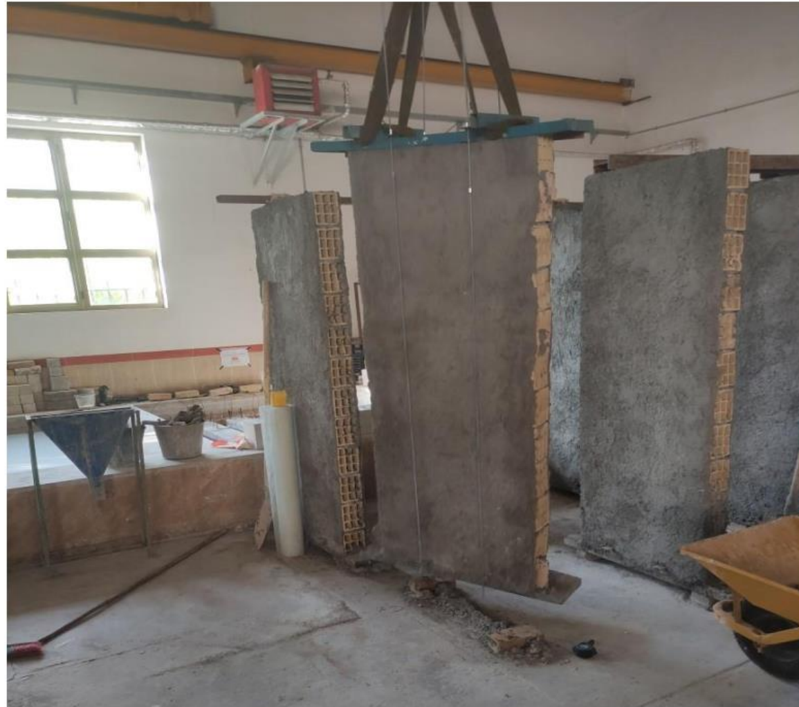
شکل ۷-۱۲: روش بلند کردن و حمل دیوارها تا جایگاه تست
