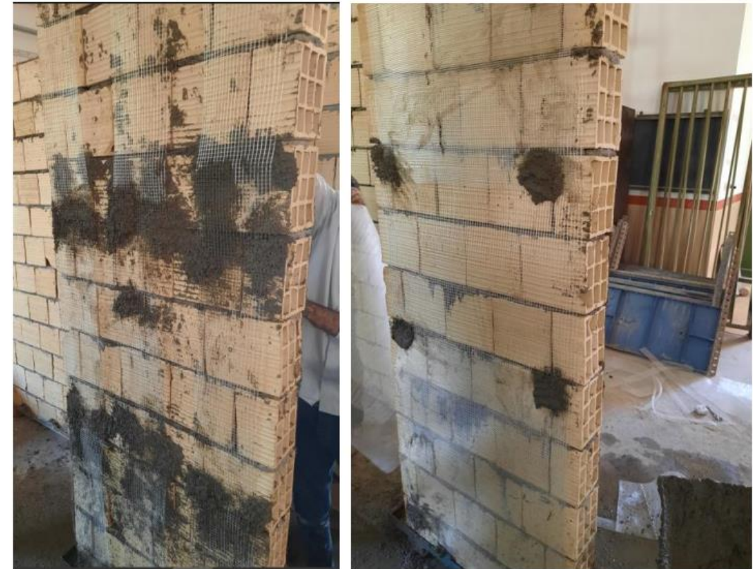
شکل ۲-۹: نحوه مسلح سازی دیوار با شبکه الیاف شیشه
