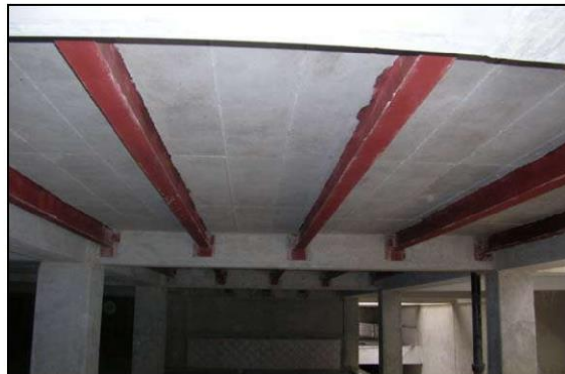
شکل ۲-۳-۵- اضافه کردن تیرک فولادی
