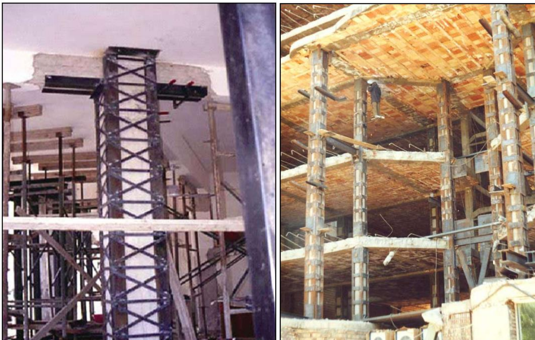
شکل ۲-۵-۱۳- بهسازی ستونهای بتنی بوسیله روکش فولادی قفسه‌ای
