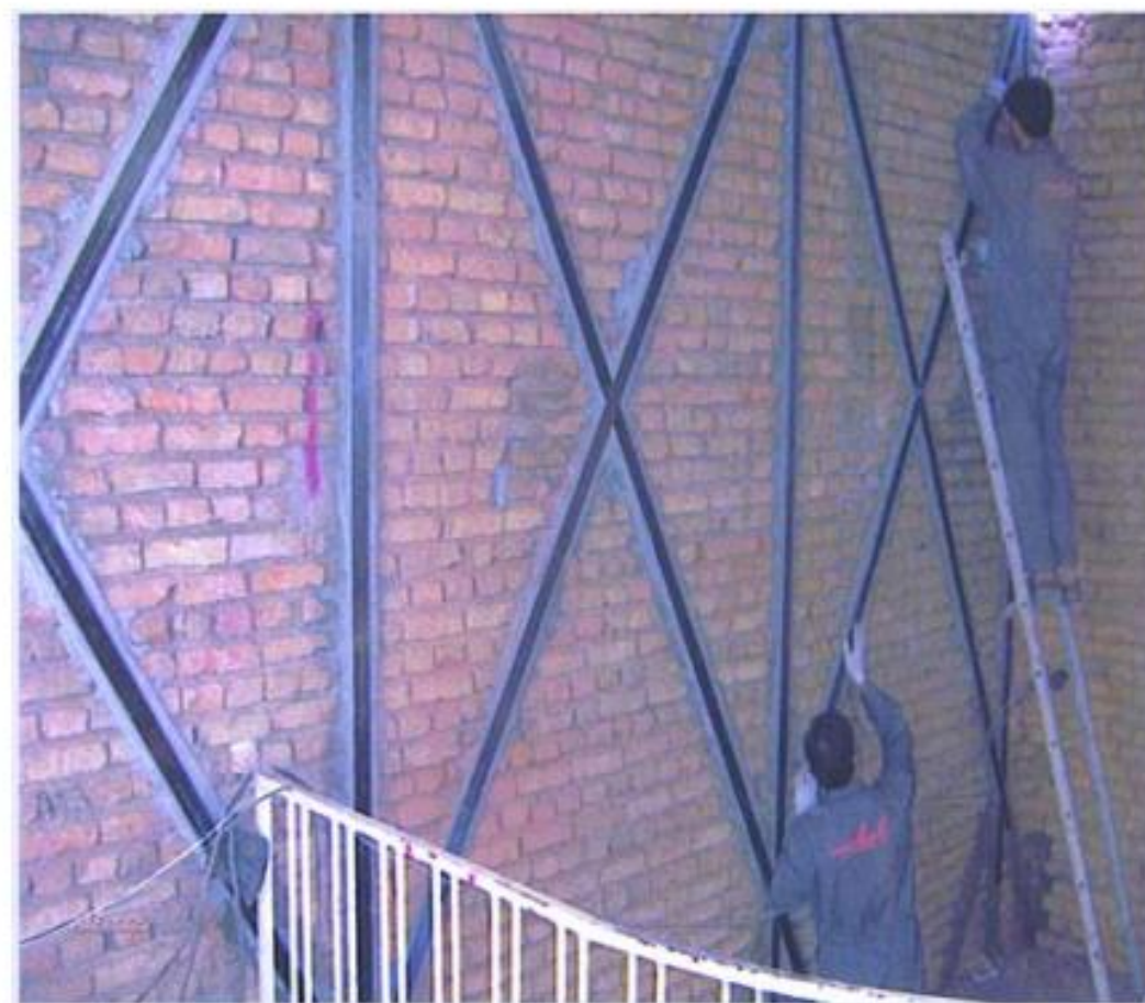
شکل ۸-۱۹ - نحوه اجرا و نصب نوارهای FRP
