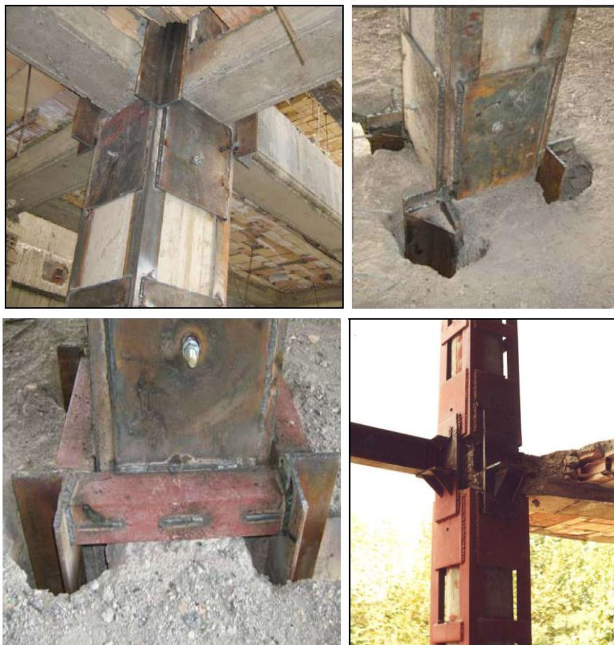
شکل ۲-۵-۱۲- نمونه‌ای از روکش فولادی جهت افزایش مقاومت خمشی ستون
