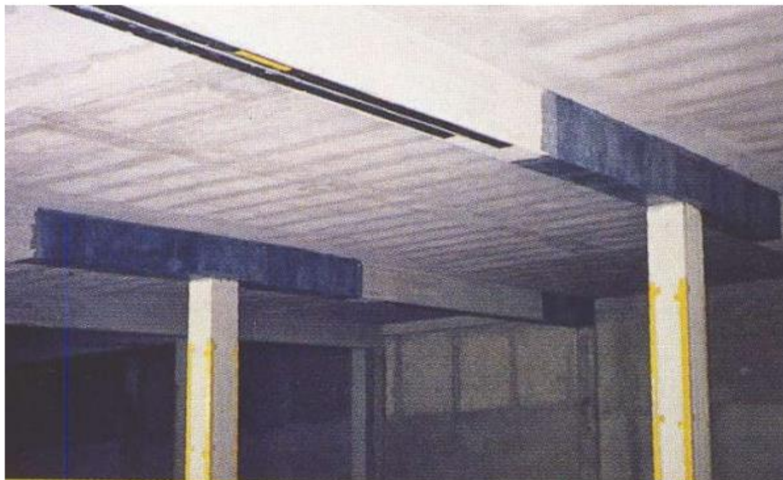
شکل ۲-۴-۸- کاربرد مصالح FRP در مقاومسازی
