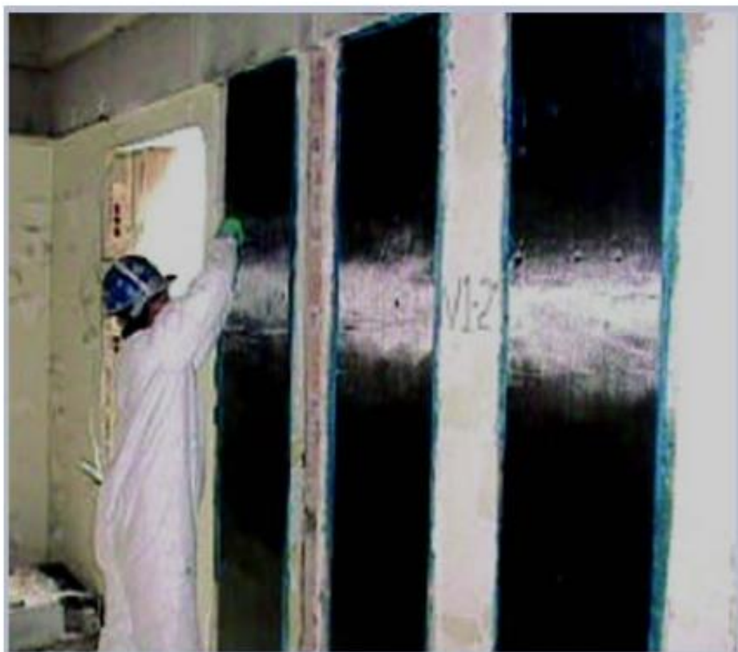
شکل ۸-۱۹ - نحوه اجرا و نصب نوارهای FRP
