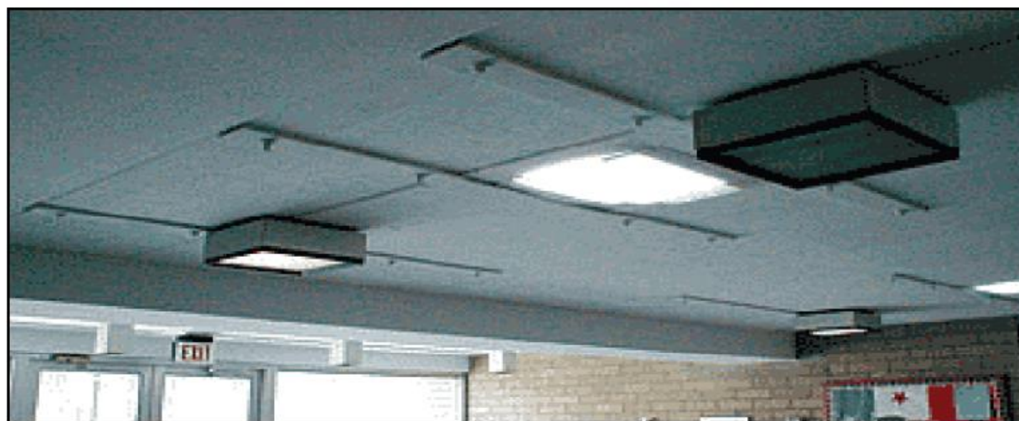
شکل ۲-۳-۷- تقویت دالها با استفاده از ورقهای فولادی
