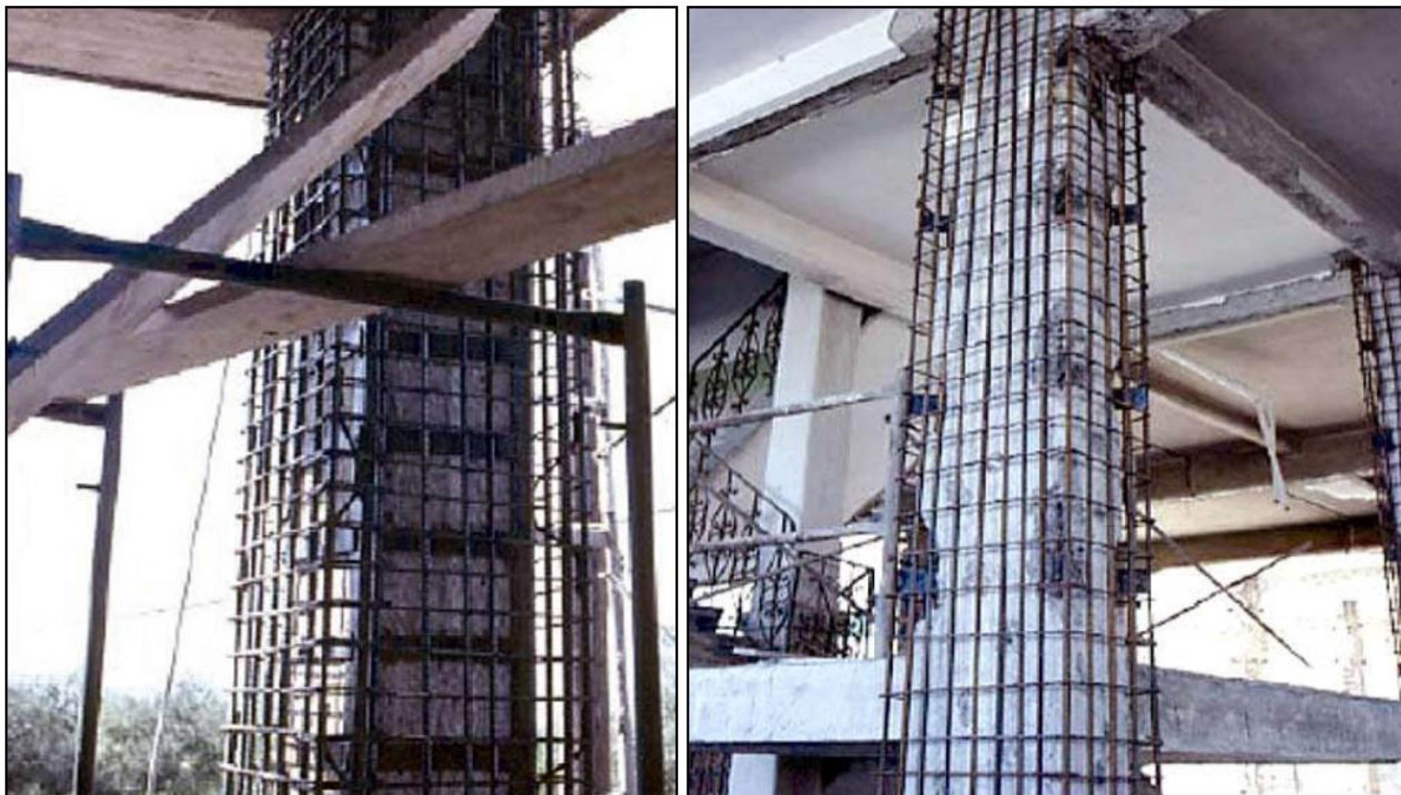
شکل ۲-۵-۹- استفاده از روکش بتنی جهت بهسازی ستون‌ها
