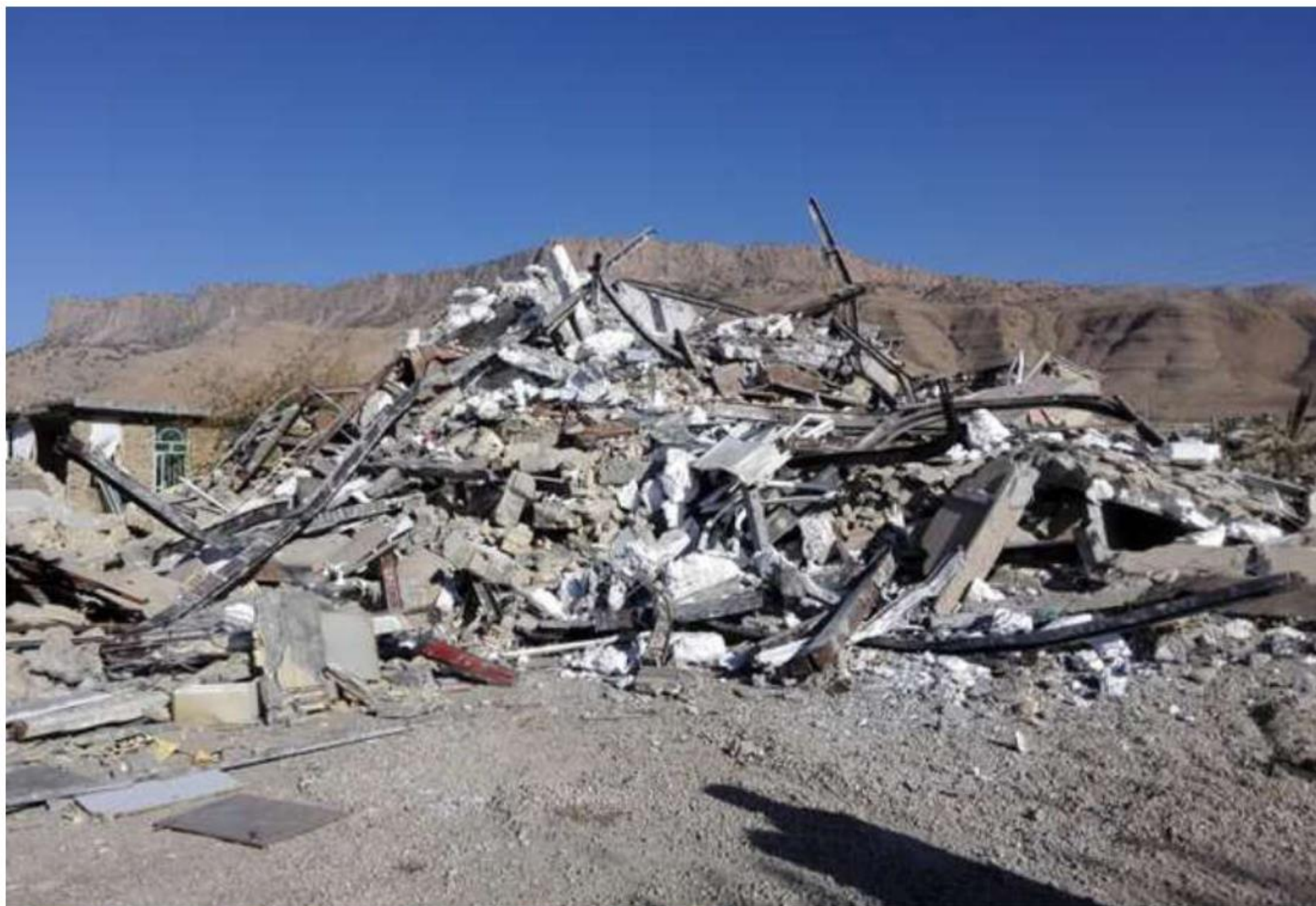
فروریزش سازه فولادی در روستاهای نزدیک سرپل ذهاب از طرف تازه آباد
