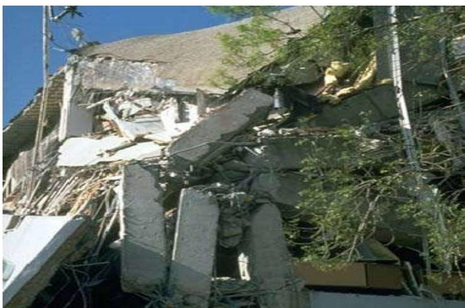
شکل ۶-۵ نمونه‌هایی از شکست در اتصالات ضعیف بتنی
