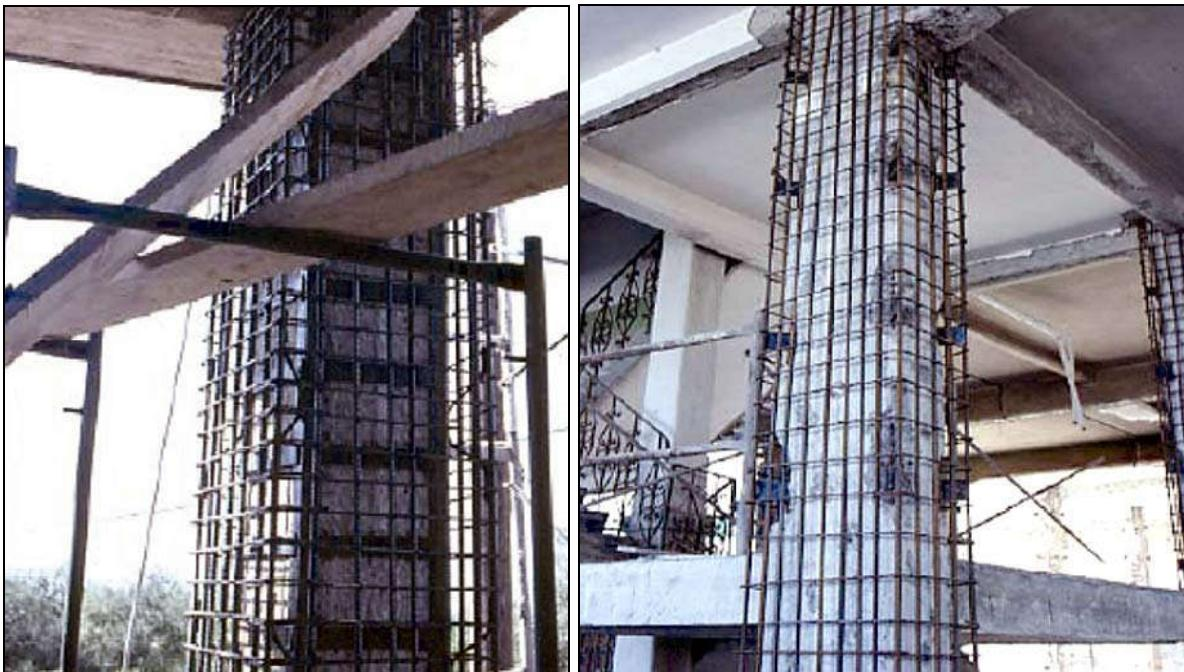
شکل ۲-۹-۵-۶- استفاده از روکش بتنی جهت بهسازی ستون‌ها
