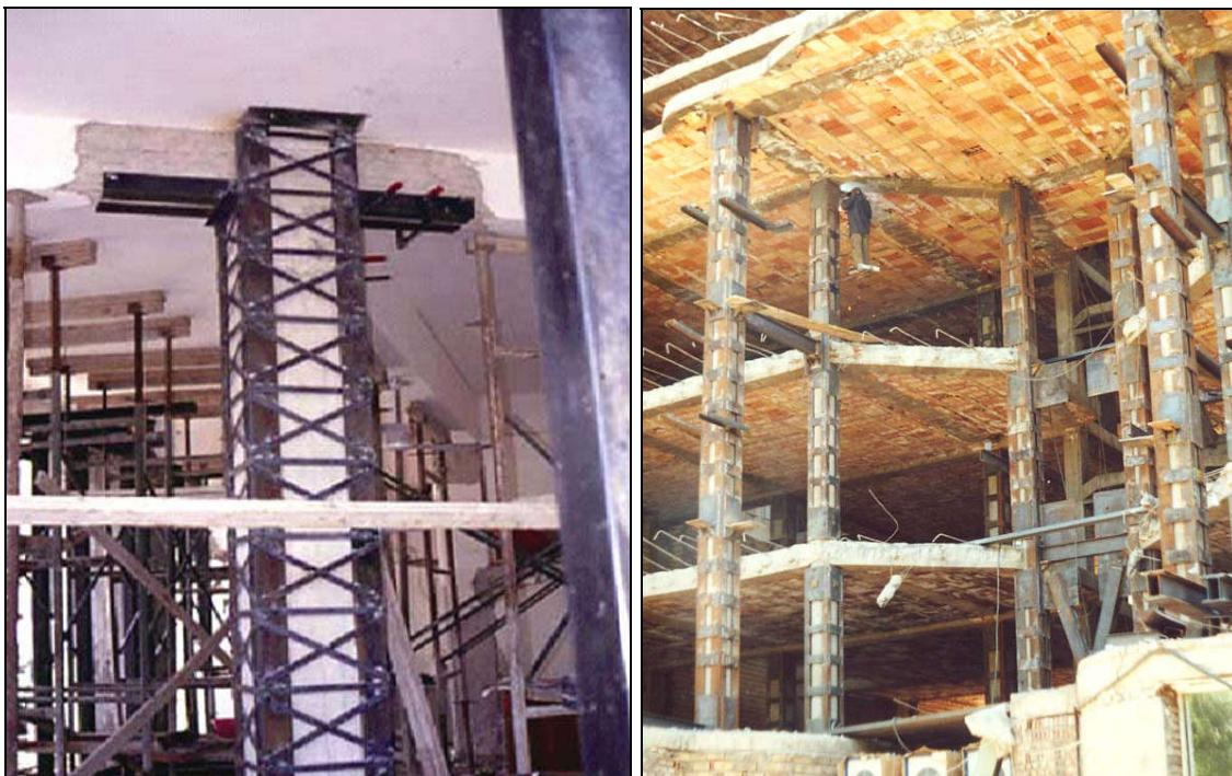
شکل ۲-۵-۱۳- سازی ستونهای بتنی بوسیله روکش فولادی قفسه‌ای
