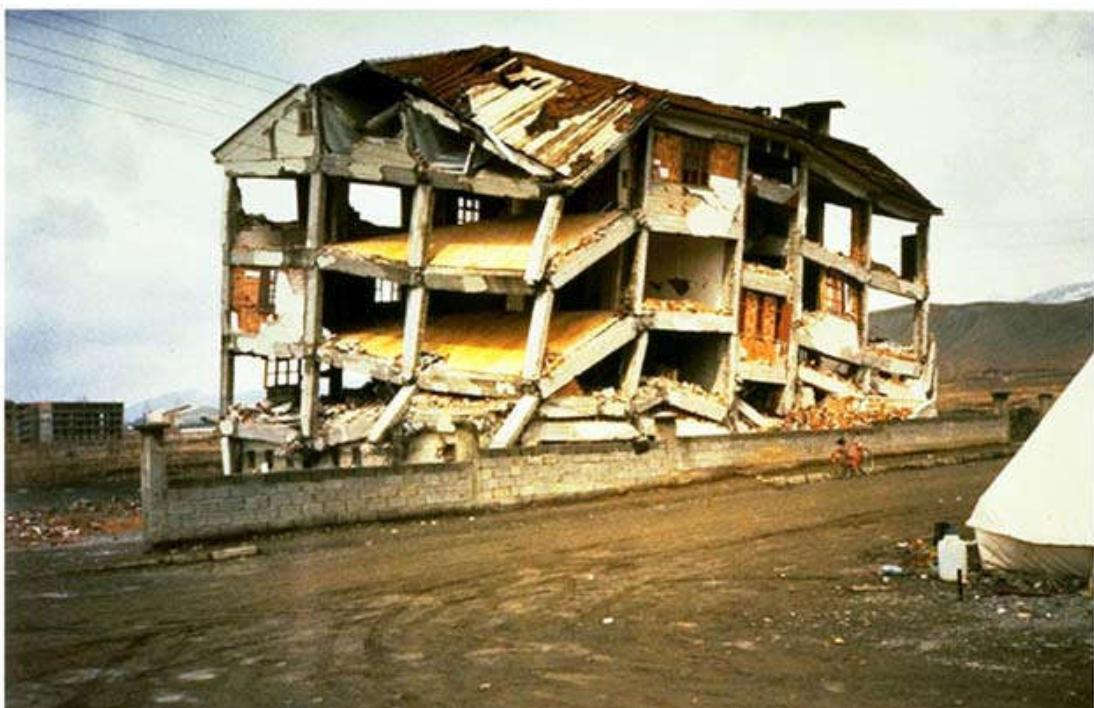
شکل ۲-۶-۲ تخریب اتصال در اثر کمبود میلگرد طولی که منجر به تخریب کلی سازه شده است.
