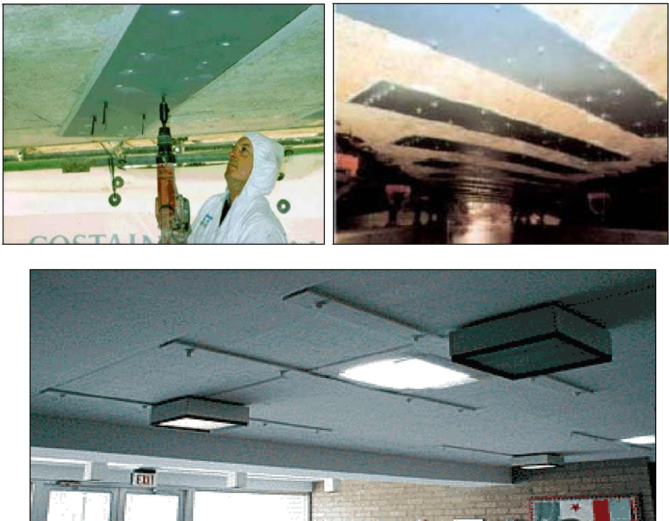
شکل ۲-۳-۷- تقویت دال‌ها با استفاده از ورق‌های فولادی
