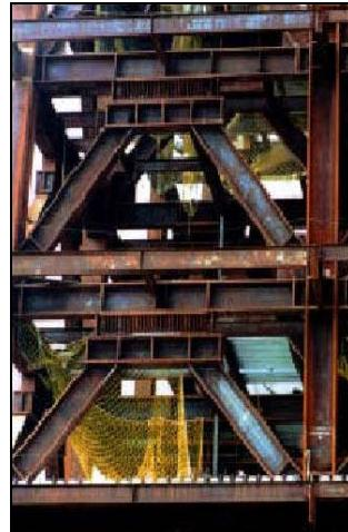
شکل ۷-۱۳- نمونه‌هایی از بکارگیری میراگر T-ADAS
