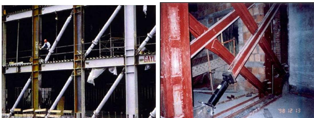
شکل ۱۹-۷-استفاده از میراگرهای ویسکوز در بادبندهای قطری
