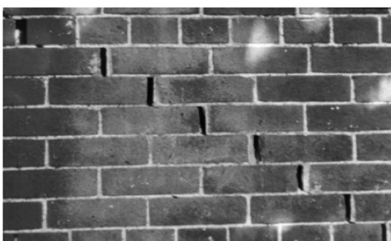
شکل ۴-۹ - لغزش درز ملات پس از ترک خوردگی قطری
