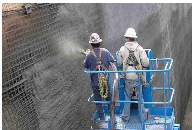
اجرای شاتکریت در دیوار بتنی
