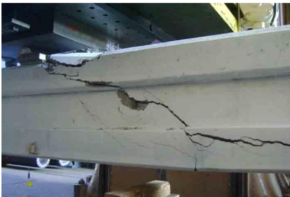
شکست تیر بتنی تحت برش
