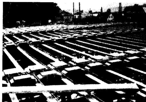
شکل ۱۶. تنظیم فواصل بین تیرچه‌ها با نصب دو بلوك انتهایی
