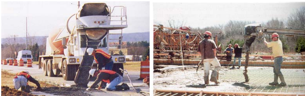
شکل ۲ ریختن بتن در نزدیکی محل مورد نیاز
