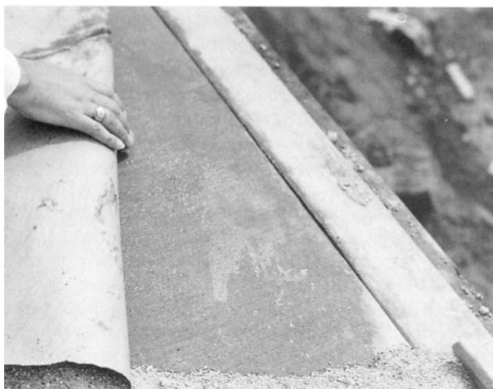
شکل ۳ عمل آوری عایقی (پوشش‌های مرکب)
