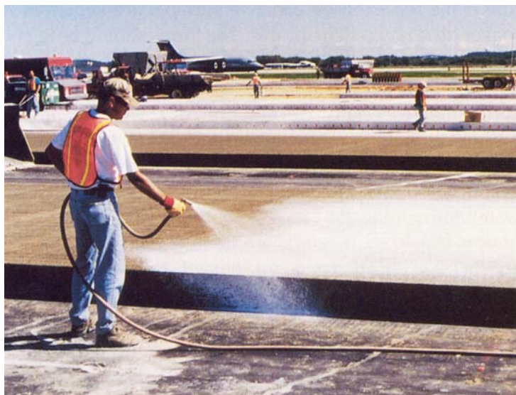
شکل ۴ روش عمل‌آوری با ماده شیمیایی غشایی
