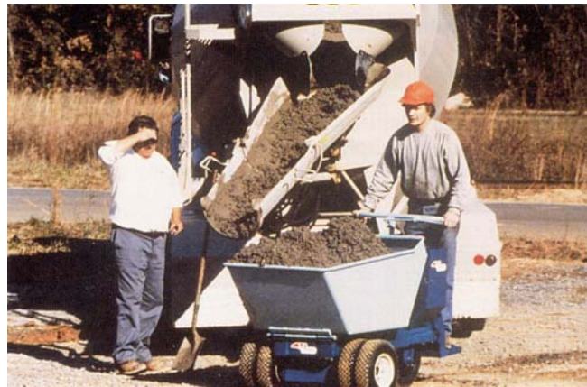
شکل ۲ انتقال بتن با استفاده از فرغون موتوری
