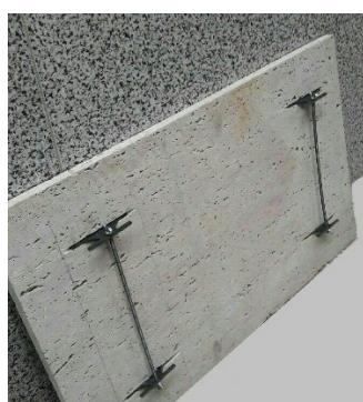
شکل ۱-۴- مهار سنگ با استفاده از ایجاد شکاف مورب و تعییه صفحات فولاد گالوانیزه،
