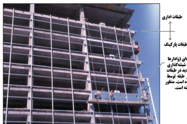
پس از تکمیل اعضاي قاب دیوار پرده‌ای (وادارها) و ریل‌ها در بعض طبقات پارکینگ، شیشه‌گذاری آغاز شده است. از آنجا که تاچه دید در طبقات پارکینگ وجود ندارد ششنه ها در هر طبقه توسط یک ریل میانی به دو بخش تقسیم شده است. منظور از تاچرد ریل تاچیت سایز قطعه شیشه است.
