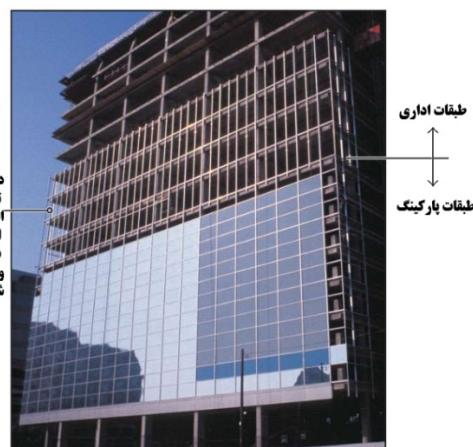
شکل ۹-۶-۹- مراحل نصب دیوارپرده‌ای شیشه‌ای درجا در یک ساختمان اداری که در آن طبقات زیرین بارکینگ و طبقات بالایی اداری است
