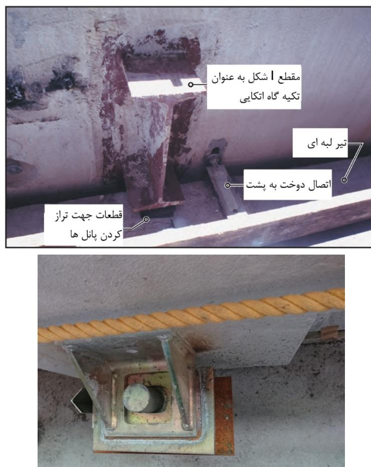
شکل ۱۰-۶- نمونه هایی از عناوین تکیه گاه انتکابی در پانل های بتنی پیش ساخته
