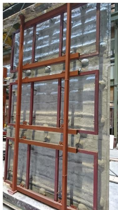
شکل ۱۱-۱۲-ب- نمای پشت یک پانل GFRC همراه با قاب فولادی
