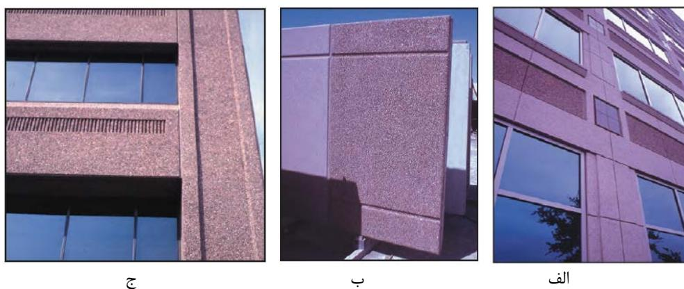
شکل ۱۰-۲- الف- پانل بتنی پیش ساخته با جزئیات سطح صیقلی ب- پانل‌های بتنی پیش ساخته با سطح سمباده‌ای کم و متوسط ج- پانل بتنی با رویه سنگدانه نمایان
