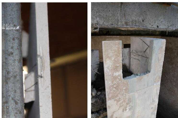
شکل ۲-۴- نمونه‌هایی از مهارهای سیمی فولادی
