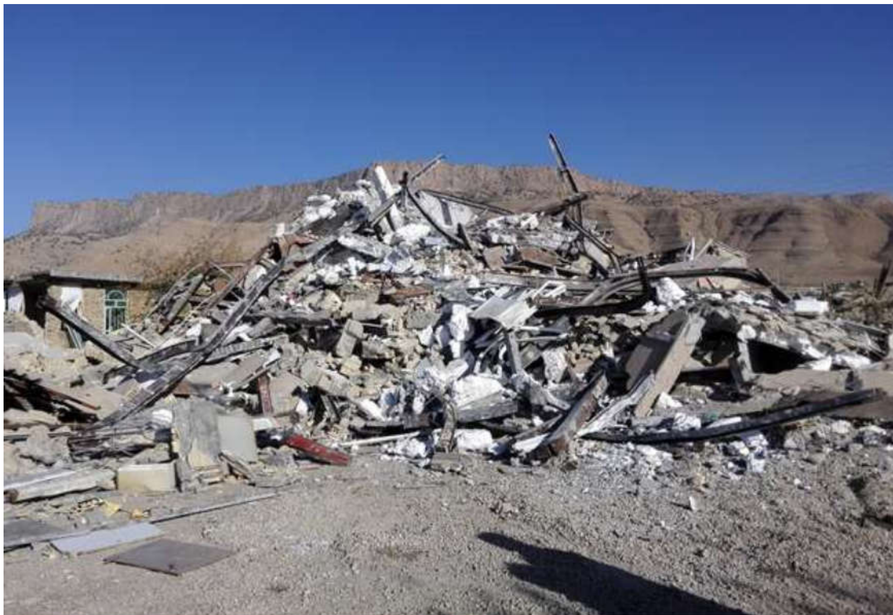
شکل ۵-۲ فروریزش سازه فولادی در روستاهای نزدیک سرپل ذهاب از طرف تازه آباد
