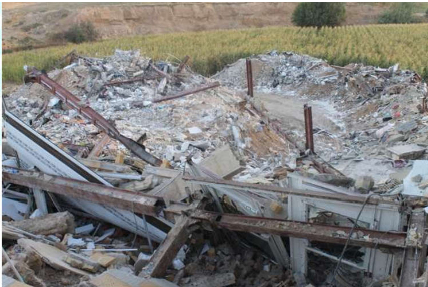
شکل ۵-۲۶ فروریزش دو ساختمان اسکلت فولادی دارای اتصال قاب خمشی و مهاربندی در دو جهت مختلف و کشته شدن ۳۸ نفر
