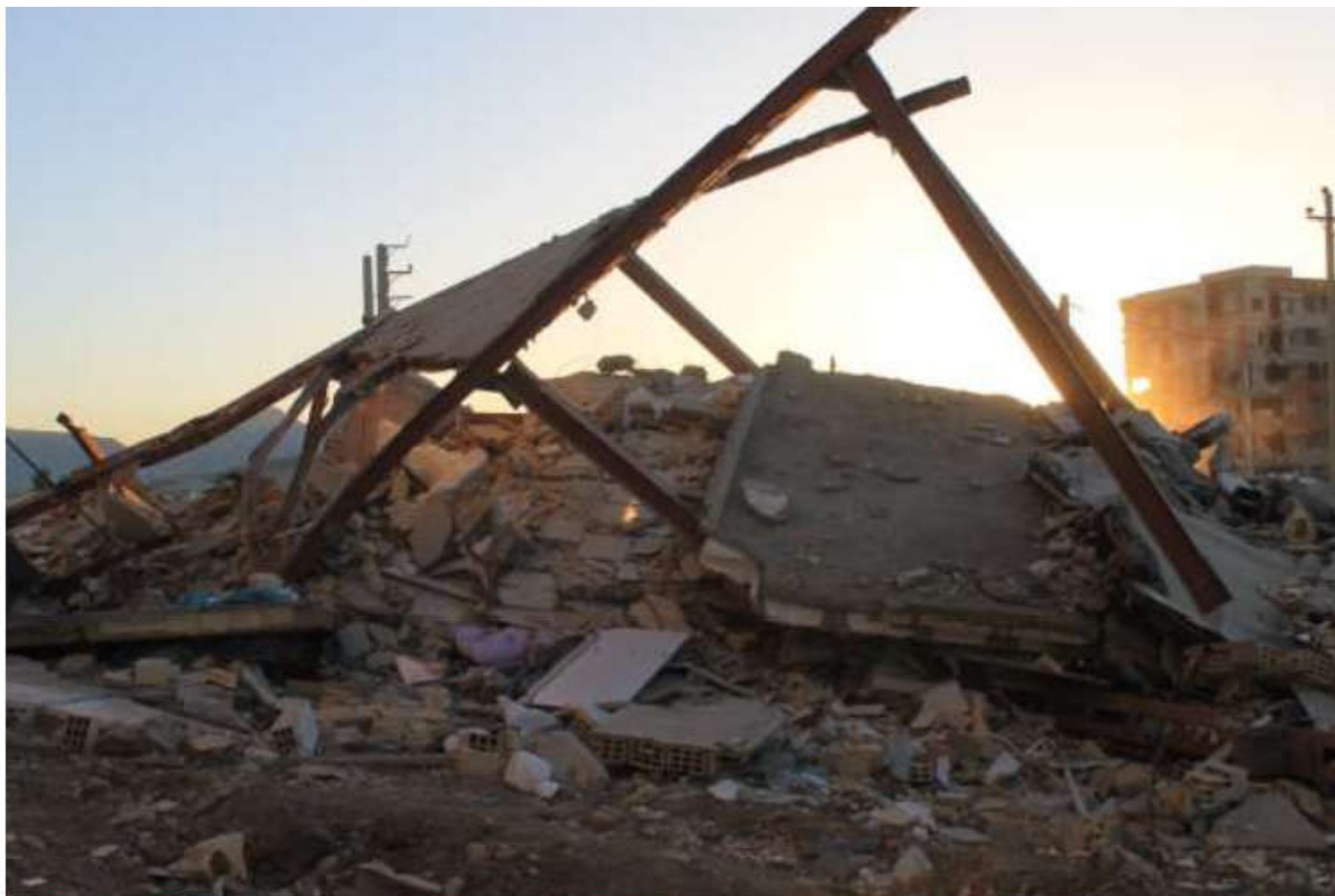
شکل ۴-۵ فروریزش سازه فولادی دارای دو سیستم متفاوت مقاوم لرزه‌ای در دو جهت (قاب خمشی و
