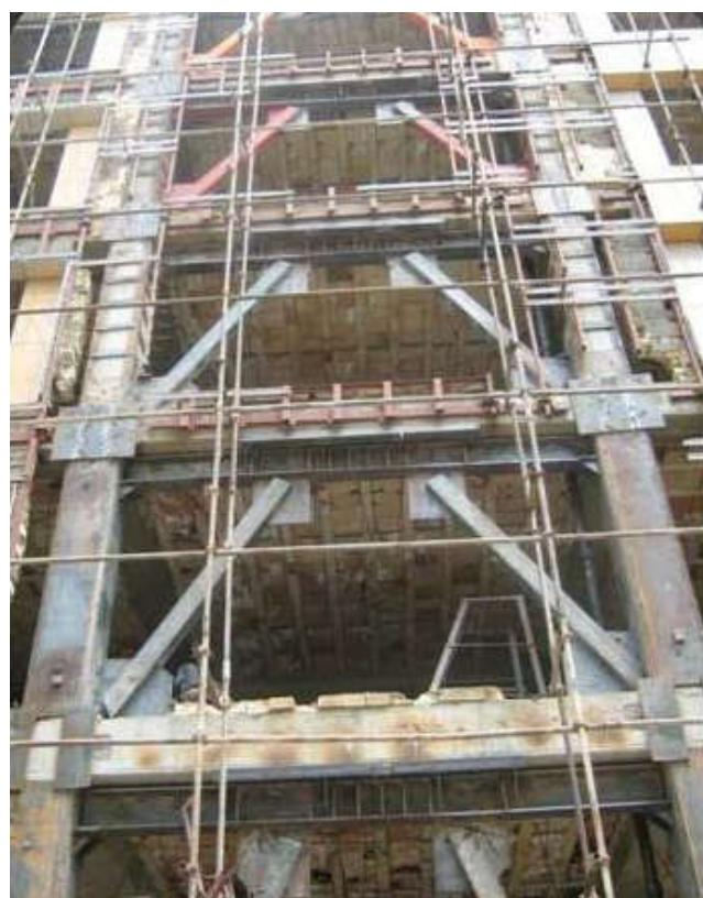
شکل ۴-۱۴- اضافه نمودن مهاربند واگرا به منظور تقویت سیستم باربر جانبی سازه
