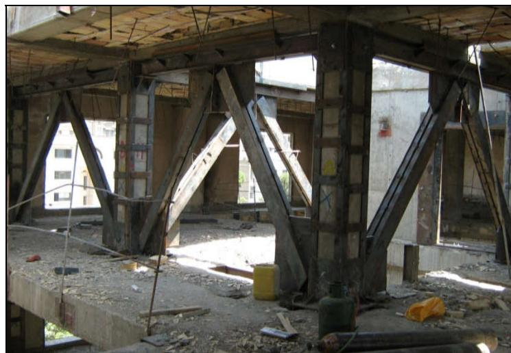
شکل ۴-۶- استفاده از مهاربند همگرای جناغی در بهسازی قاب‌های بتنی
