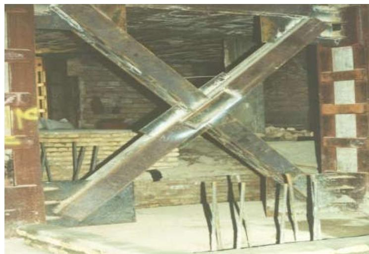
شکل ۴-۷- استفاده از مهاربند همگرای ضربدری در بهسازی قاب‌های بتنی
