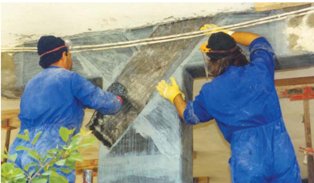
شکل ۲۹-۶-۲ جزئیات تیپ استفاده از FRP در مقاوم‌سازی اتصالات
