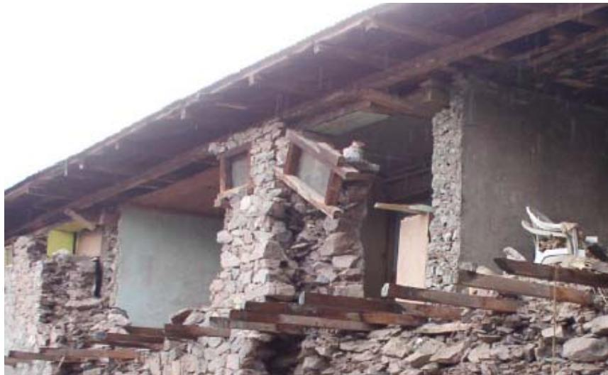
خرابی به علت ضعف در مقاومت خمشی دیوارهای بنایی
