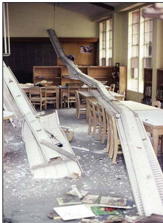
شکل ۱۰-۲- آسیب به سیستم روشنایی در هنگام زلزله
