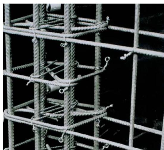
شکل ۳-۱۶- اجرای جزئیات مناسب و شکل‌پذیر در ستون‌ها
