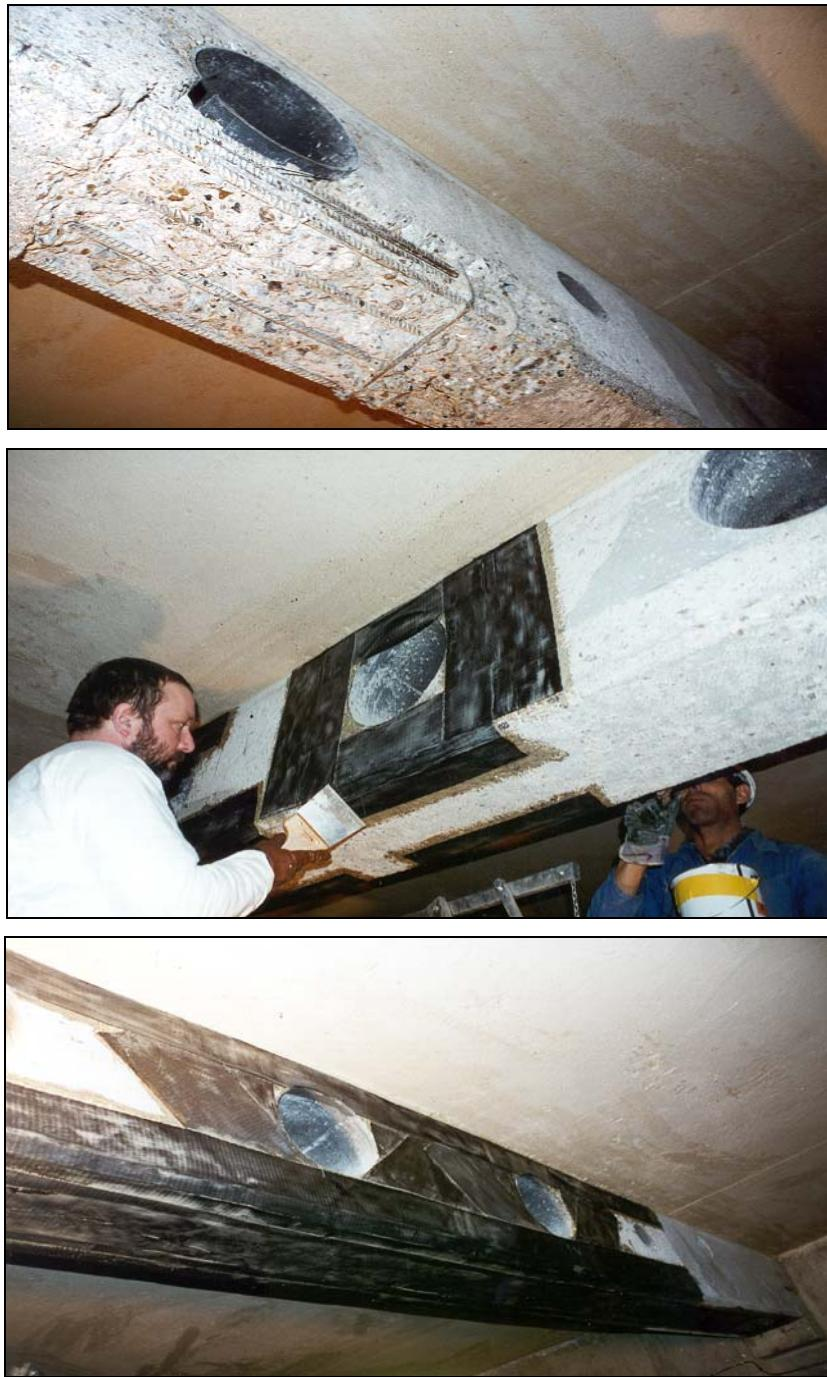
شکل ۲-۴-۱۵-۴- تقویت موضعی سوارخ‌ها در تیر FRP
