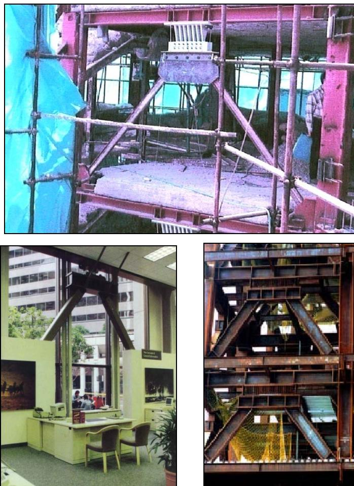
شکل ۷-۱۳- نمونه هایی از بکارگیری میراگر
