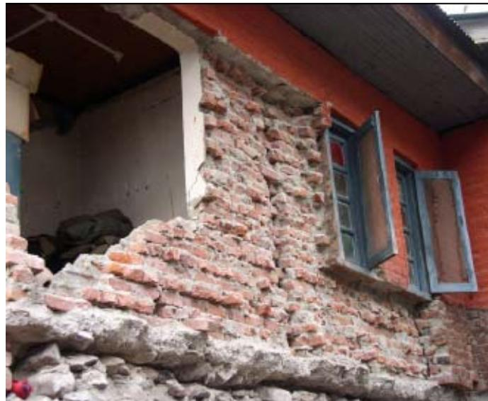
شکل ۶-۶ نمونه‌ای از خرابی خارج از صفحه دیوارهای بنایی
