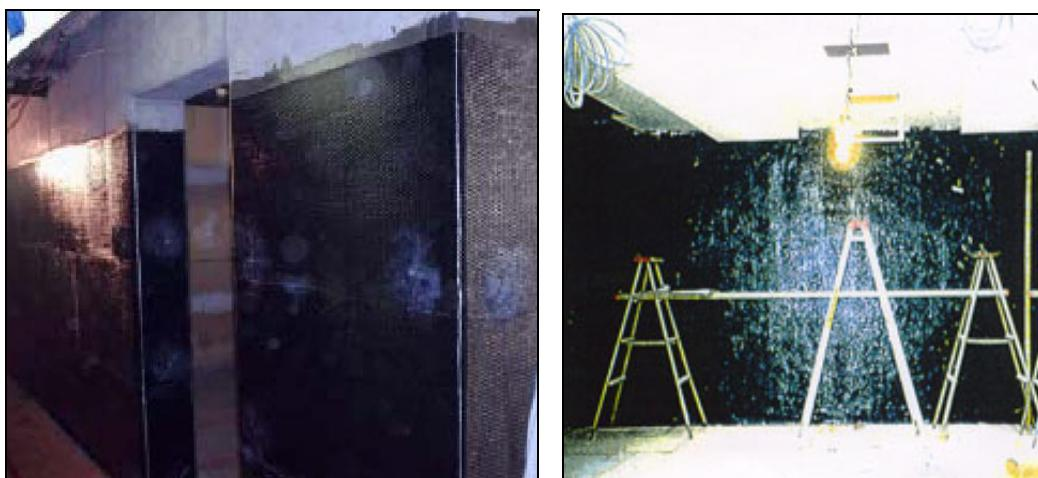
شکل ۴۲-۴ - تقویت کلی دیوارهای برپی بوسیله مصالح FRP
