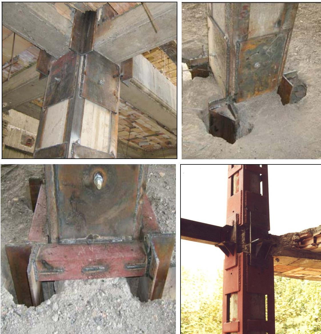
شکل ۱۲-۵-۲- نمونه‌ای از روکش فولادی جهت افزایش مقاومت خمثی ستون
