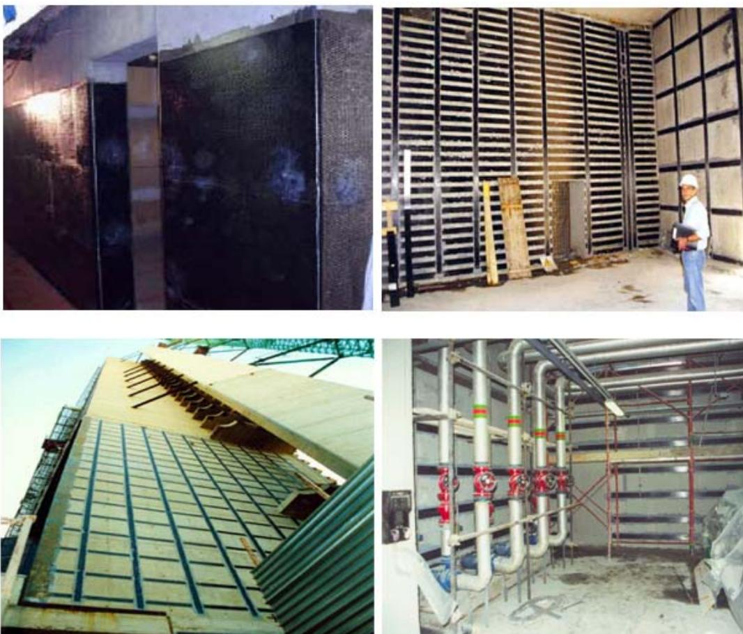
شکل ۴۱-۴ - تقویت دیوار برپی با سیستم FRP
