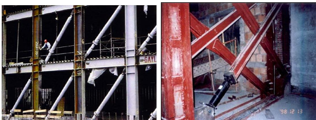
شکل ۱۹-۷- استفاده از میراگرهای ویسکوز در بادبندهای قطری
