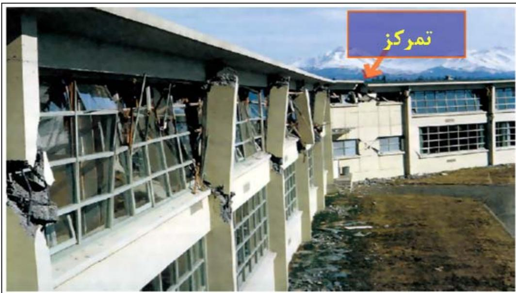
شکل ۳-۱۹-۳- تمرکز تنش در گنج یک ساختمان L شکل
