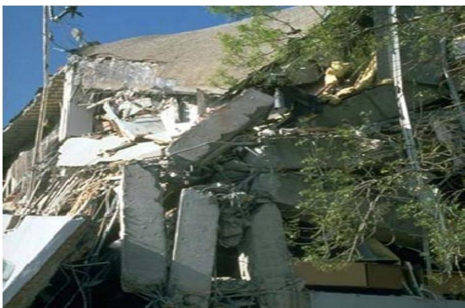
شکل ۲-۶-۵ نمونه‌هایی از شکست در اتصالات ضعیف بتنی
