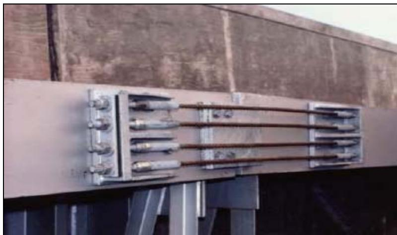
شکل ۲-۲۰-۴- روشن استفاده از پیش‌تنیدگی موضعی در مقاومسازی تیرهای بتنی
