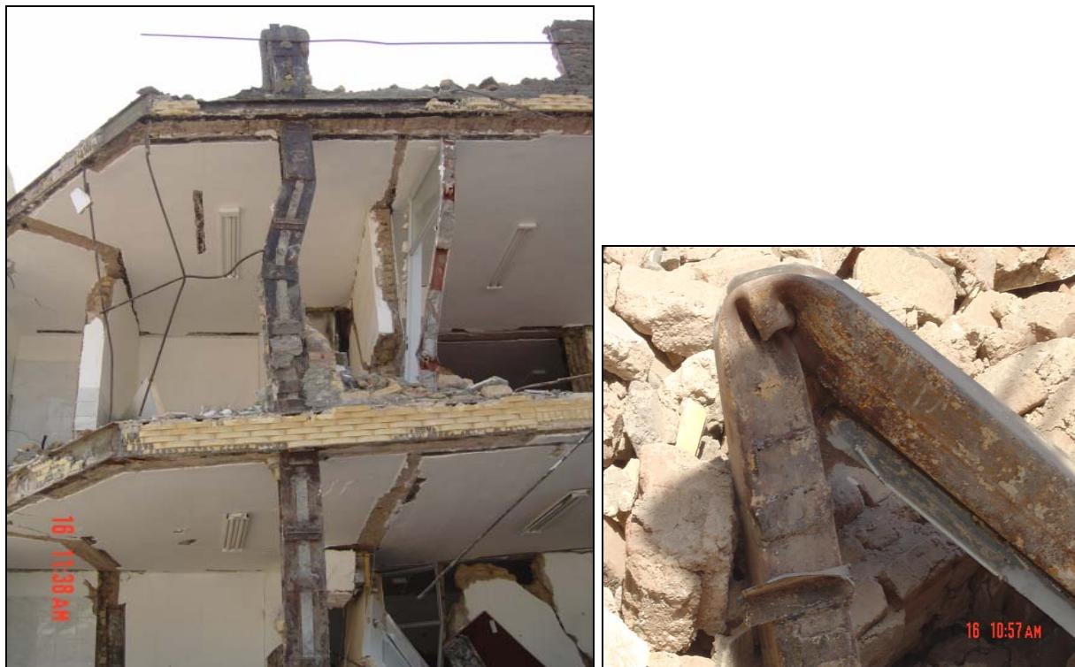
شکل ۲-۵-۱۹- نمونه‌ای از خرابی ستون‌های فولادی
