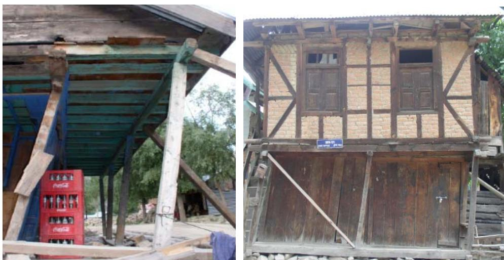
شکل ۳۶-۹ تغییرشکل جانبی دائم سازه به علت عدم وجود بادبندهای مناسب و یا اتصالات ضعیف بادبندها
