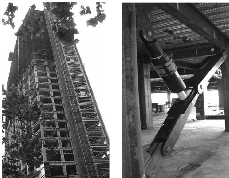
شکل ۷-۲۷- اشکال ترکیبی از نصب میراگر در ساختمان‌های بلند
