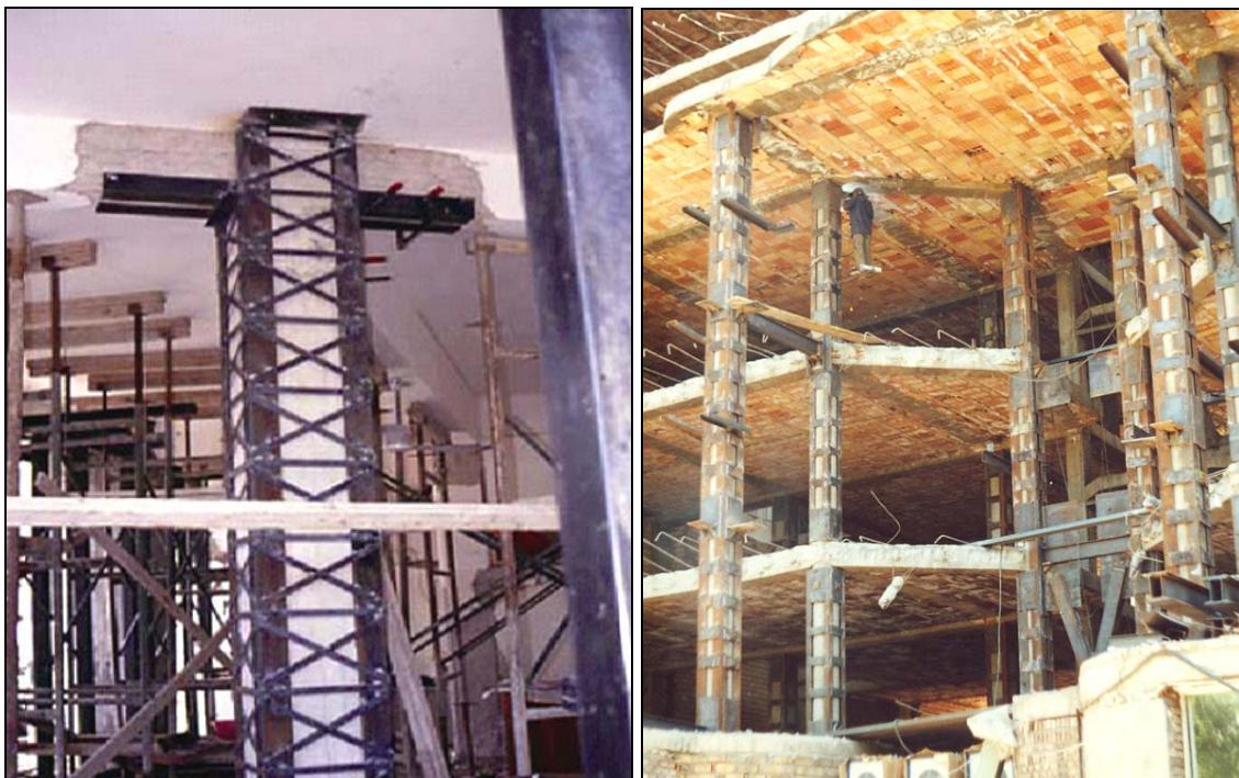
شکل ۲-۵-۱۳- بھسازی ستونهای بتنی بوسیله روکش فولادی قفسه‌ای
