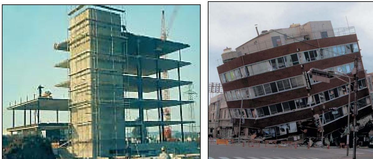
شکل ۳-۶- فاصله زیاد بین مرکز جرم و مرکز سختی و خرابی ناشی از ایجاد پیچش
