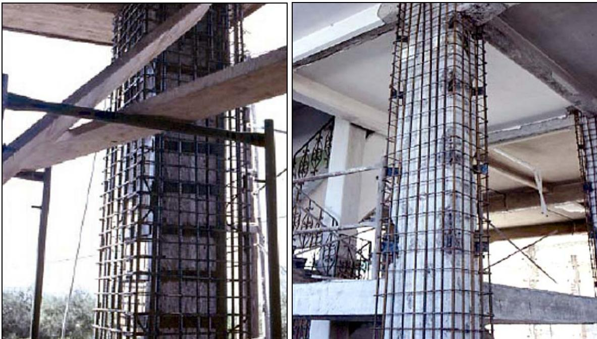
شکل ۲-۹-۵- استفاده از روکش بتنی جهت بهسازی ستون‌ها
